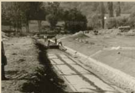
Foto 3: Ausbau des Gspringsbaches mit Matten
