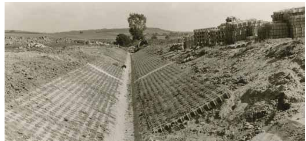
Foto 1: Ausbau des Bachbettes in den 1970er Jahren
